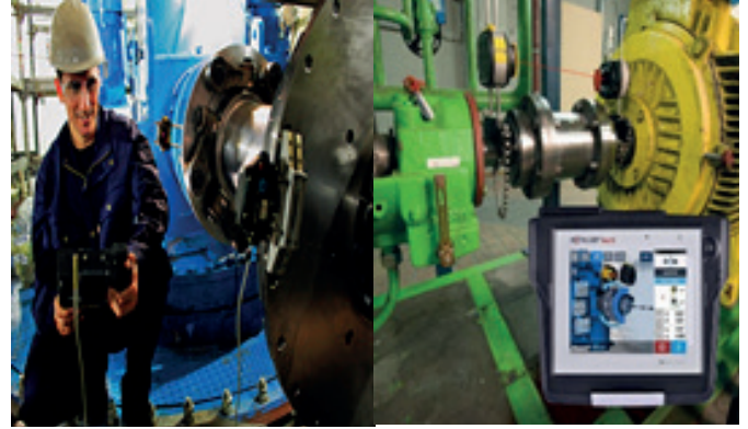
Figura 2. Máquinas alineadas por Láser Óptico.
